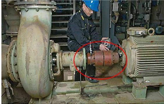
Figure.44. Transmission de mouvement par accouplement d'un moteur électrique vers une pompe.
